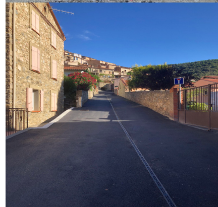
Travaux Rue de la Mairie
