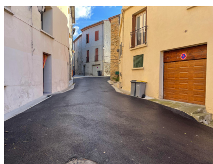
Rue d'Aragon après travaux
