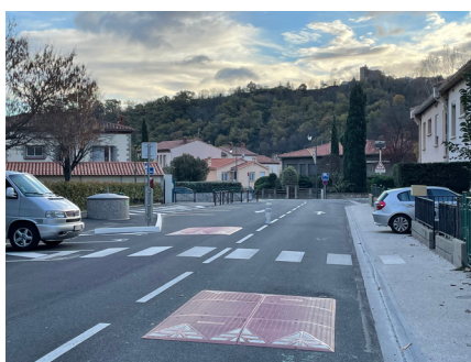
Aménagement Avenue d'en Cassa aux abords du Parc à jeux
