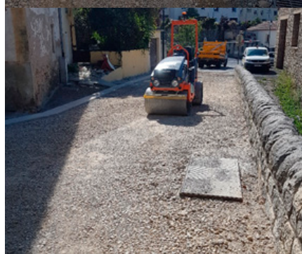
Travaux en cours Rue du Foyer et Rue d'Aragon
