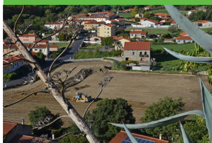
Premiers travaux de terrassement sur le terrain de la nouvelle Mairie
