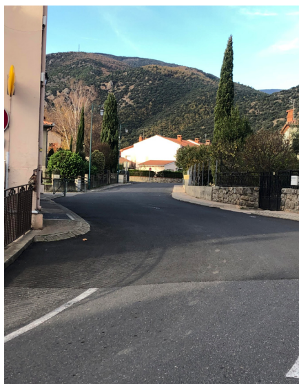
La portion située entre l'école et la rue des Sports qui fera l'objet d'importants travaux de sécurisation
