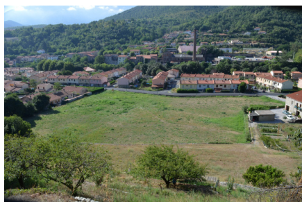
Terrain avant travaux d'aménagement
