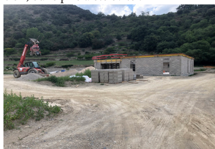
Travaux de la nouvelle Mairie fin juin
