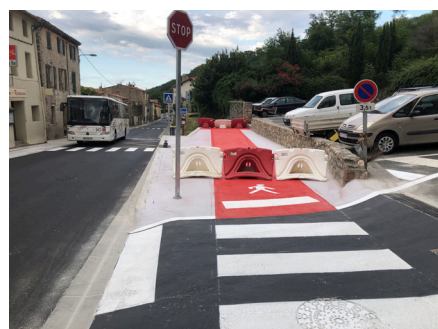
Travaux de sécurisation de l'accès à l'arrêt de bus
