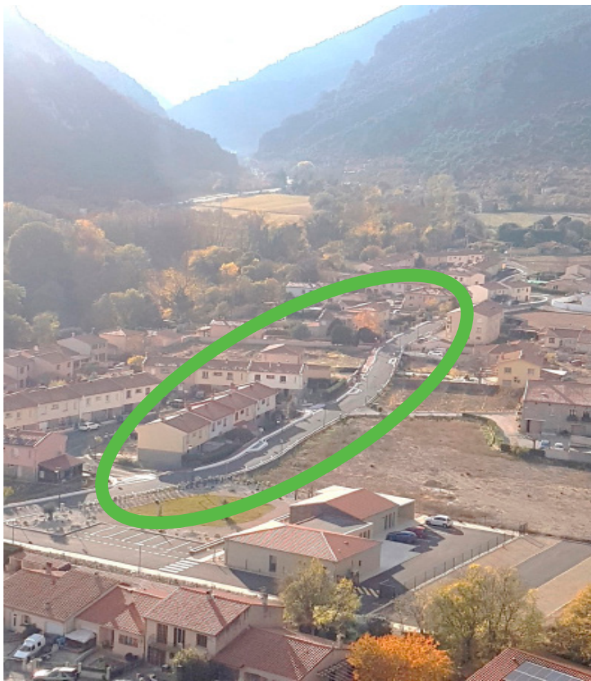
Aménagement de l'avenue d'en Cassa
