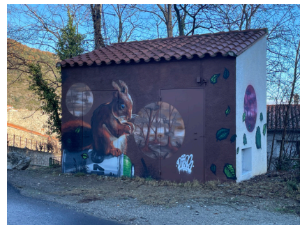
Superbe décoration sur le transformateur
