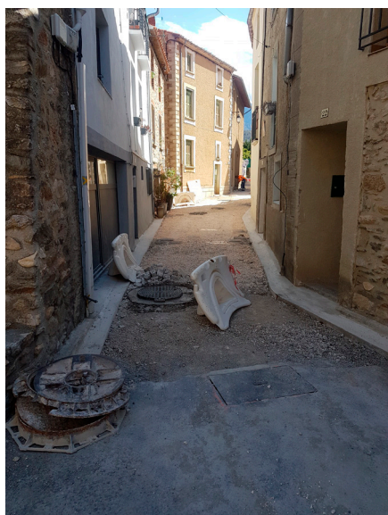
Travaux Rue d'Aragon à Sirach
