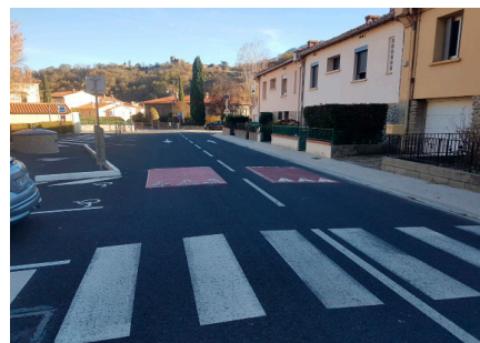
Implantation d'un coussin berlinois supplémentaire avenue d'en Cas-sa
