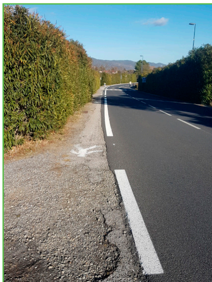
Cheminement piéton sur la RD26A ou Route de Conat
