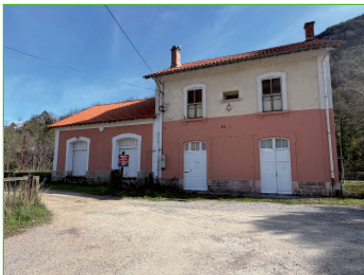
Travaux de la gare avant / après
